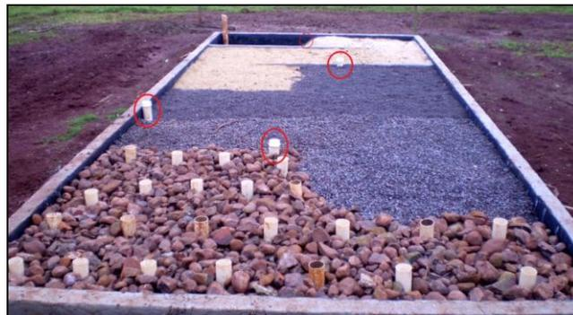
Figura 2: Canos de inspeção instalados.
