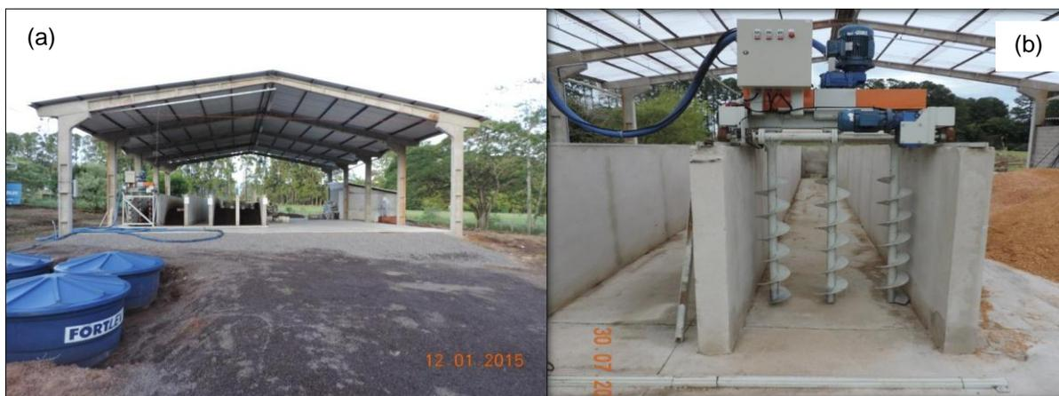
**Figura 2.** Vista geral da plataforma de compostagem (a) e revolvedor vertical de compostagem (b).
